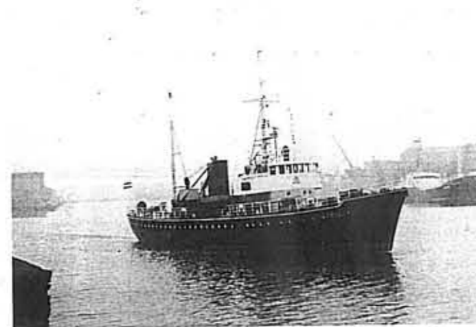
De „Pollux”, in haar originele gedaante, varend als loodsboot tot 1980. Daarna werd het schip ingericht als het expeditievaartuig „Plancius”. Het schip werd gebouwd door de Gebr. Pot in Bolnes, lengte 45,87 m over alles, breedte 8,43 m, holte 5,86 m, uitgerust met een 650 pk Smit/MAN hoofdmotor. In 1988 kocht de Rotterdamse reder Joon het schip om het als particulier jacht „Waterproef” in te richten. Nadat de rederij failliet was gegaan, werd het schip in 1992 verkocht, waarbij de originele naam „Pollux” in ere werd hersteld. Het schip is nog steeds als motorjacht in de vaart. Foto Albert Boes.
